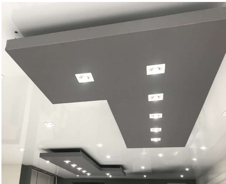
Cadre en forme de «L» sur mesure avec spots encastrés et profilés rebordés.
